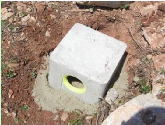
Photo 5 : Positionnement du caisson dans le trou ©Pauline Demonfaucon
