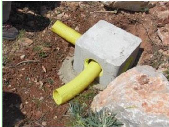
Photo 6 : Mise en place des gaines dans le caisson ©Pauline Demonfaucon
