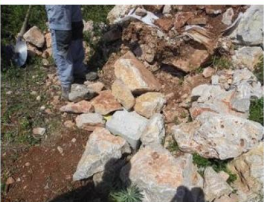
Photo 7 : Recouvrement du caisson avec de grosses pierres ©Pauline Demonfaucon
