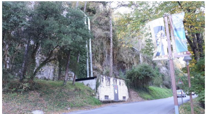
4. Conduites en encorbellement
