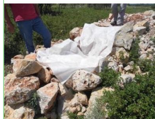
Photo 10 : Installation du géotextile ©Pauline Demonfaucon
